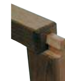
カマホヅ組 下への荷重強度が強い家作りに使用される組立方法
